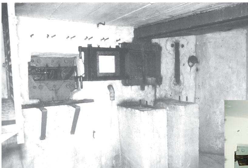
Vue d'ensemble des deux créneaux de la casemate. Sous la dalle on remarque le bi-rail supportant le canon antichar.
